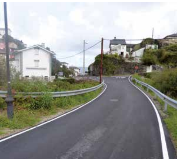
Reparación tras el saneamiento en Ortiguera
